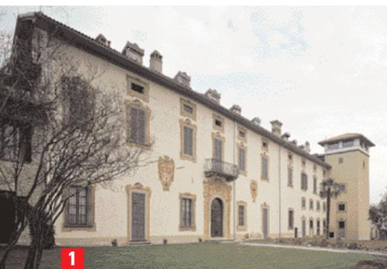
**1** Progettazione e ristrutturazione del Castello di Cenate. La tecnica con la quale è stato affrontato il restauro, è anche un po' il «leit motiv» dell'impresa: la reversibilità. Il principio, cioè, secondo il quale ogni elemento architettonico, strutturale o impiantistico, debba arrecare il minor danno possibile in termini di compatibilità tra i materiali e possa essere smontato per permettere l'originario utilizzo dei locali o la sostituzione con una tecnica più moderna e meno invasiva.
